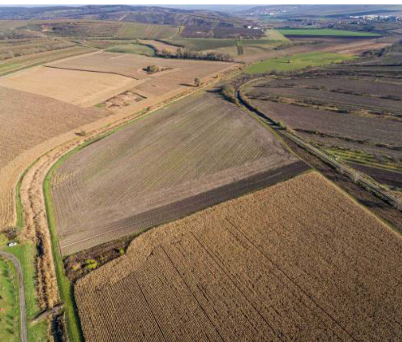
Napřímené a ohrázkované koryto říčky Trkmanky před revitalizací. Foto: Povodí Moravy s.p.
