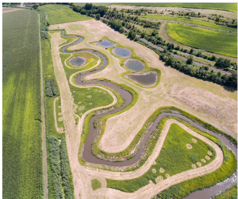
Posílení schopnosti krajiny zadržovat vodu v praxi. Úpravy říčky Trkmanky u Velkých Pavlovic realizovalo Povodí Moravy s.p. Zdařilou revitalizaci následně doplnily stovky nových dřevin.
