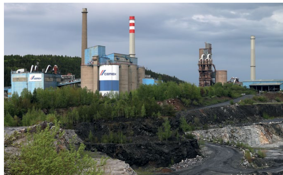
Foto 2.1: Cementárna společnosti Cemex v Prachovicích spaluje hlavně plastové odpady, část z nich dováží ze zahraničí. Foto: Jan Losenický, Arnika.
