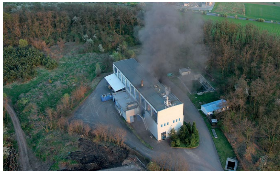
Foto 7.2 Také nesoulad mezi technologií spalovny a nevyzkoušeným dioxinovým filtrem může vést k havárii spalovny, jak k tomu došlo v dubnu 2013 ve spalovně nebezpečných odpadů v Lysé nad Labem (Arnika, 2013). Foto: Archiv Arniky.
