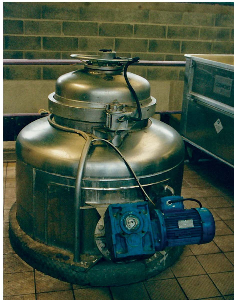
Foto 8.5 Autokláv francouzské firmy Ecodas instalovaný v jedné z francouzských nemocnic. Foto: Jindřich Petrlík, Arnika.
