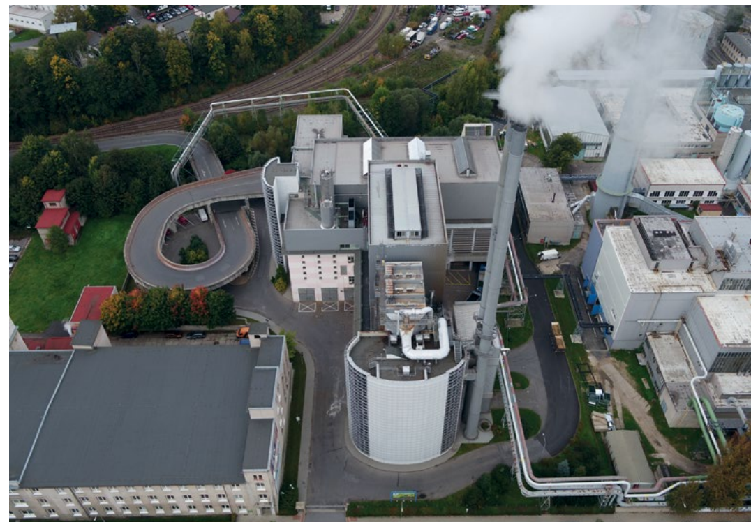
Foto 2.2: Spalovna komunálních odpadů (ZEVO) Termizo, a.s. Liberec, jak vypadala v roce 2021. Foto pořízené z dronu: Marek Jehlička (skyworker.cz).
