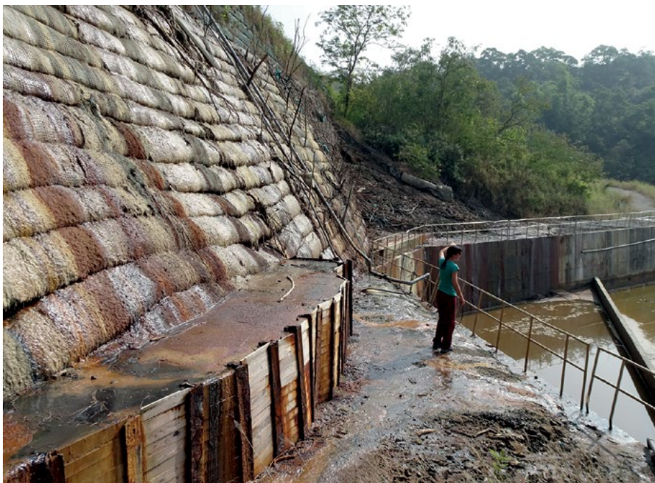
Foto 5.21 Ve stabilizovaném popílku z lokality Yan Chao v jižním Tchajwanu byly zjištěny vysoké koncentrace rtuti a olova (Bell et al., 2023).
