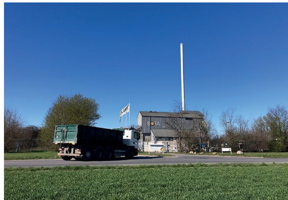
Foto 10.2 Spalovna komunálních odpadů na ostrově Bornholm bude patřit mezi ty, které se chystá Dánsko uzavřít (Christensen et al., 2021). Foto: BOFA.
