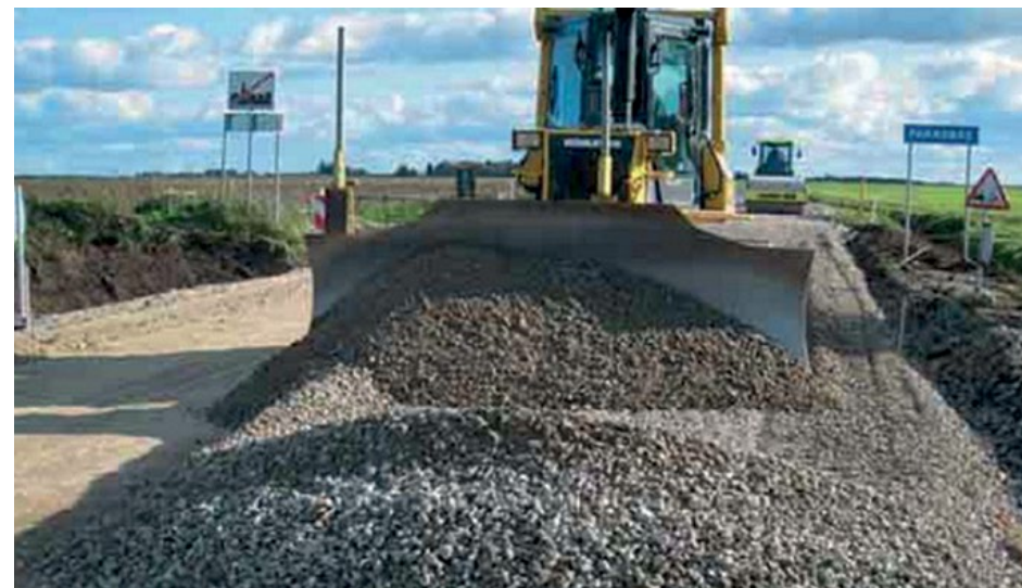
Foto 10.7 Také popel a struska ze spalovny Iru se používá při stavbě silnic tak, jako je tomu v Nizozemsku. Foto: Jäätmed Artiklite arhiiv.
