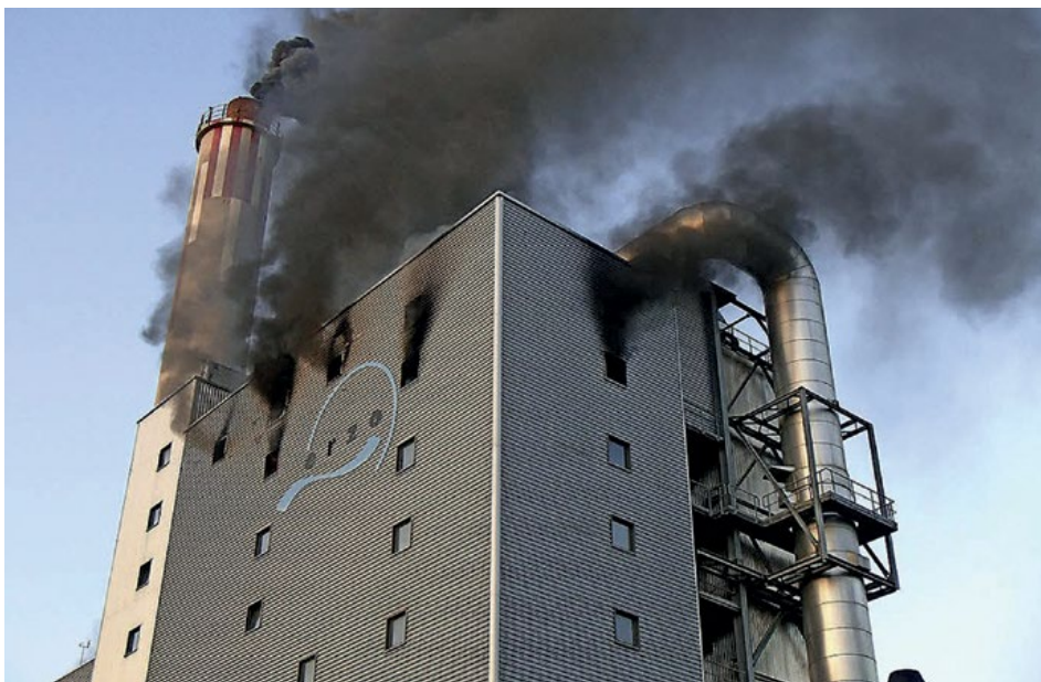
Foto 7.6 Požár ve spalovně ve švýcarském kantonu Aargau 28. května 2015 zasáhl část na čištění spalin. Z oken v jednom z vysokých podlaží vycházel černý dým (badische-zeitung.de, 2015). Foto: Kanonspolizei, Aargau, Švýcarsko.
