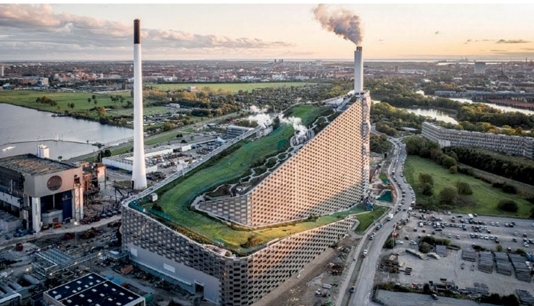
Foto 10.3 Do největší dánské spalovny komunálních odpadů Amager Bakke známé tím, že na její střeše je sjezdovka, se musí ročně dovážet až 90 tisíc tun odpadů ze zahraničí, aby se naplnila její příliš velká kapacita. Foto: https://www.youtube.com/watch?v=B1a8bGMAUvI .
