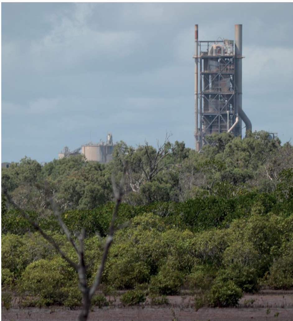
Foto 5.17 Cementárna společnosti Cement Australia Fisherman's Landing v Gladstone v australském státě Queensland zkušebně spaluje hasicí pěny obsahující PFAS, přestože nedosahuje vytyčenou míru likvidace těchto látek. Cementárna je v sousedství mangrovových bažin, kde mimo jiné vzácné karety kladou snůšky vajec, viz foto 4.10 (Limpus et al., 2013). Foto: Jindřich Petrlík, Arnika.
