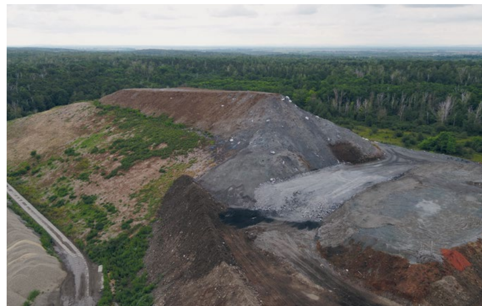
Foto 3.16 Hora odpadu v zadní části skládky v Benátkách nad Jizerou je převážně popel z malešické spalovny. Foto: Marek Jehlička (skyworker.cz).
