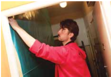
Příprava místnosti před odstraňováním azbestových trubek.
