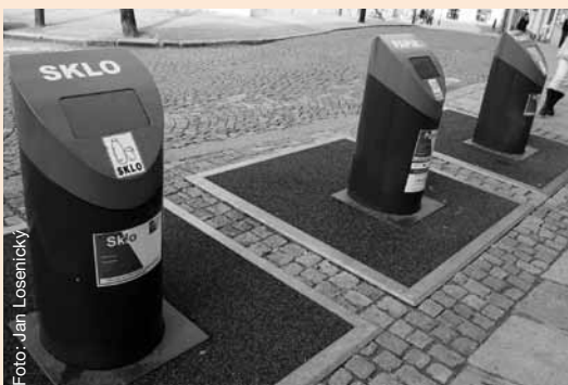
Podzemní kontejnery ve staré části města Písek.
