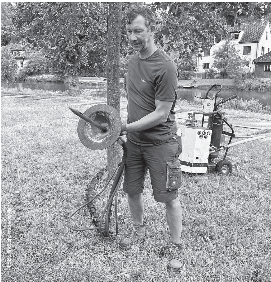
Půdní injektáž se provádí pomocí speciálního injektážního stroje.
