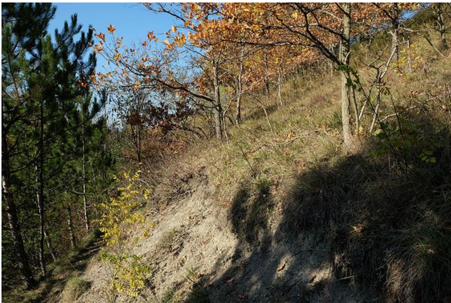
Stráň mezi Pátkem a Košticemi svahovou erozí obnažená místa v nejprudších částech svahu.
