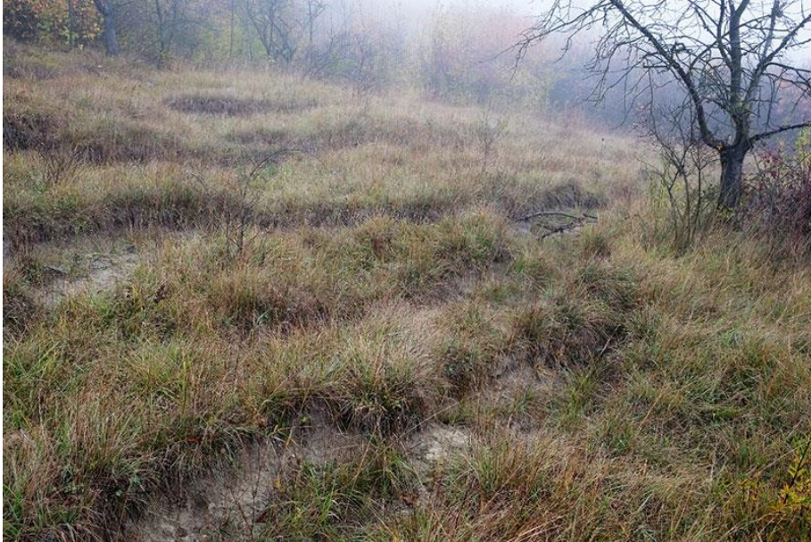
Stráně pod vrchem Rohatec u Duban, vrchní část nedávného sesuvu.
