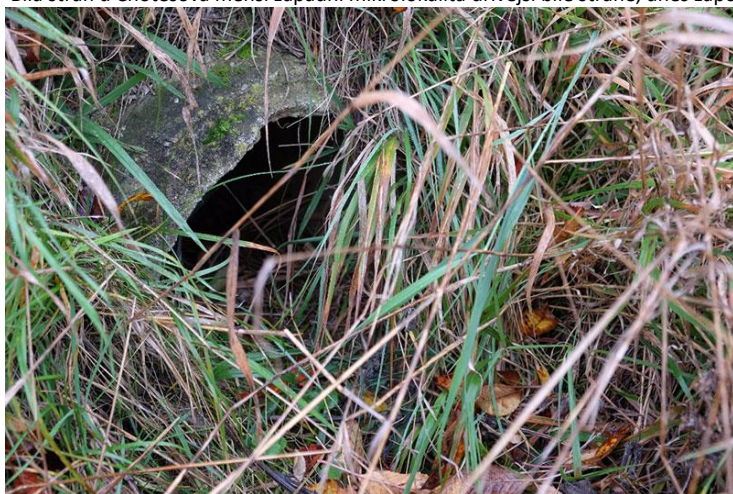
Bílá stráň u Chotěšova menší západní mikrolokalita dřívější bílé stráně, ústí potrubí na dvou místech spodního okraje stráně.
