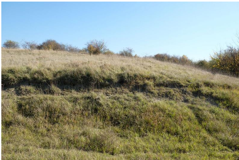
Stráně u trati mezi Slatinou a Chotěšovem, celkový pohled z železniční trati.
