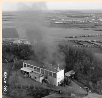
Spalovna v Lysé nad Labem
