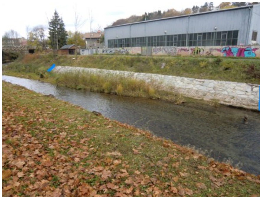
Obrázek č. 2: Hráz a dno zpevněné betonem a kamením.
