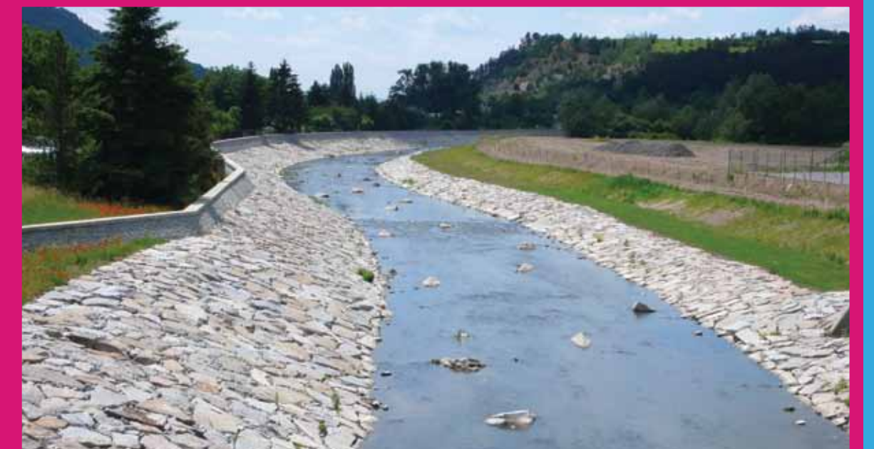
Vydlážděné koryto Litávky u Popovic nad Královým Dvorem. Příklad úpravy, která zhorší průběh případné větší povodně, a navíc omezí život v řece a schopnost jejího samočištění. Vodní koryto je zbytečně málo zavodněné a silně opevněné svahy zabírají příliš mnoho z průtočného profilu, tvarová a hydraulická členitost je celkově nedostatečná.
